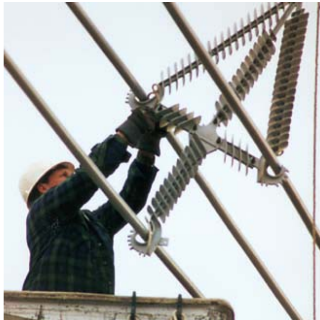
نصب خطوط کابل های فاصله دار ۶۹ کیلو ولت
