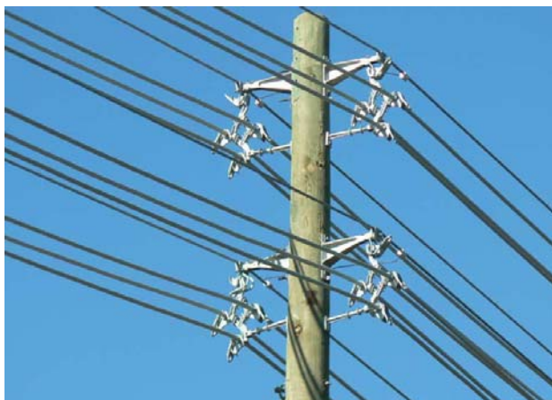
اجرای چند مدار بر روی یک پایه
